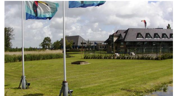
Figuur 2. Bestaande situatie Wagenweg 1 (bron: hotel Van der Valk)
