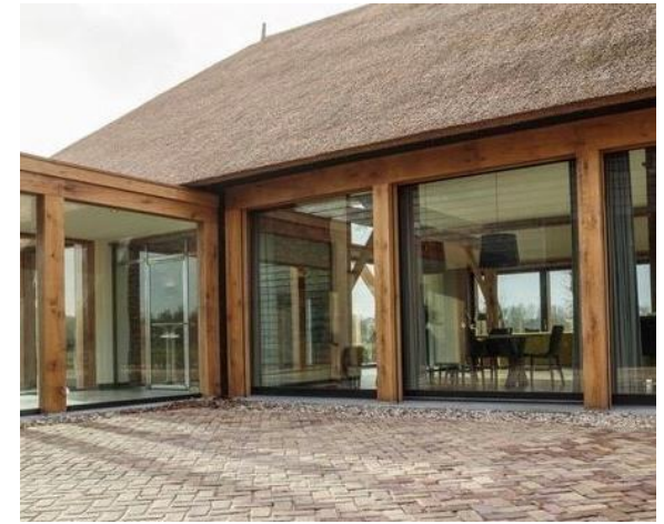
Figuur 26. Ondergeschikte bouwdelen met een plat dak en gevels gekenmerkt door veel glas (bron: hotel Van der Valk)
