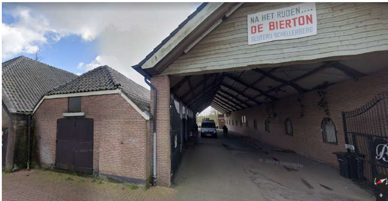
Afbeelding 3.2 Afbeelding locatie waar balts- en aantikgedrag is waargenomen. De overkapping (rechts) betreft een dichte kolom met stalen frame en houtwerk. Hierin zijn geen geschikte openingen gevonden. Het is daarmee aannemelijk dat de soort in het monumentale gebouw (links) zit.
