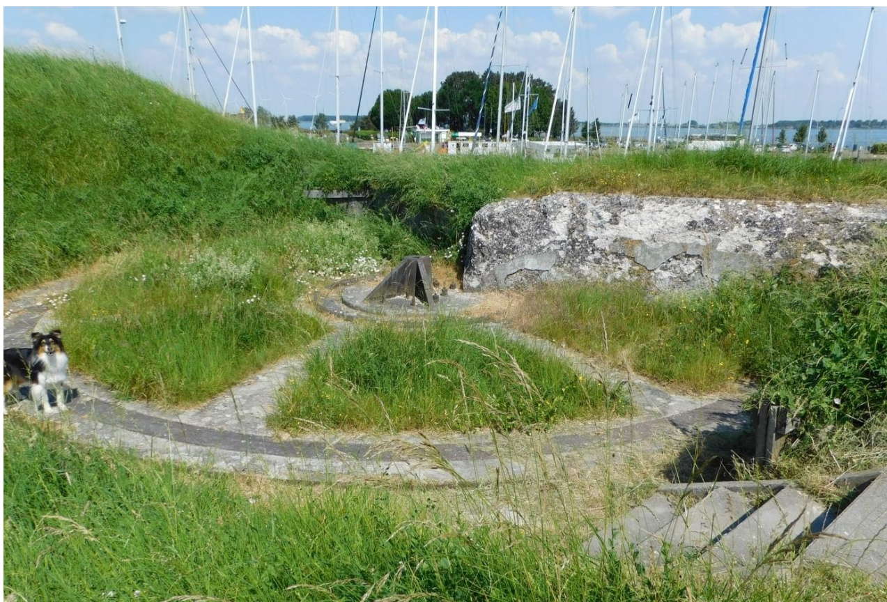
Figuur 14 - Geschutsbedding met spilkussen van het 24 cm kanon, dat kon meer dan 180° draaien om een spil.
