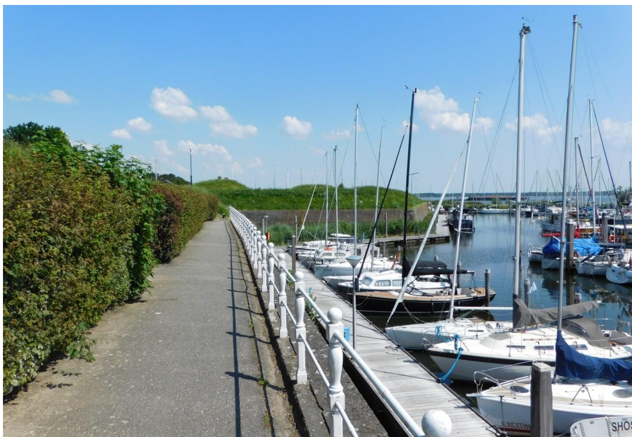
Figuur 12 Zicht op bastion Groningen vanuit het zuidoosten, de courtine VI-VII; de bekledingsmuur is van hieruit goed zichtbaar.
