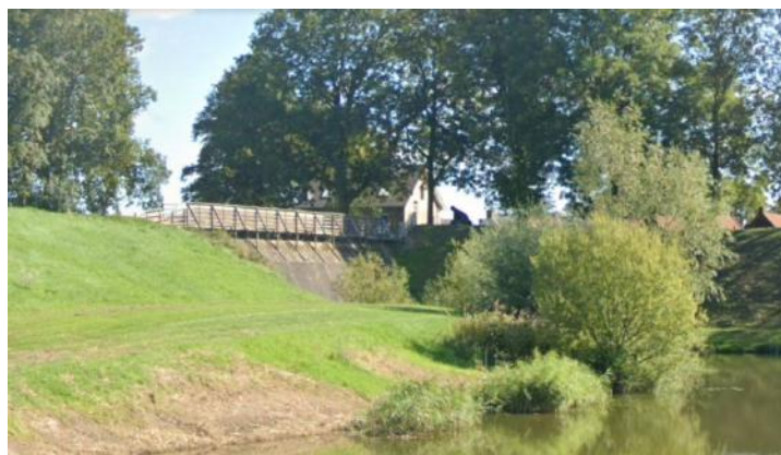
Figuur 22 -Voorbeeld wandelverbinding Westbeer in Willemstad; de verbinding is gemaakt door de aanleg van een grondwal aan de zuidzijde van de muur (foto juli 2023).
