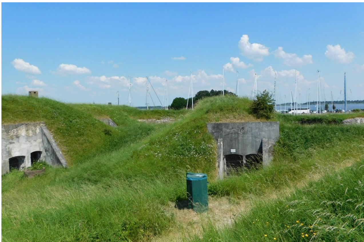
Figuur 13 - Met aarde bedekte gebouwen op bastion Groningen, links het kruitmagazijn uit 1865, gewijzigd in 1884, rechts het batterijstation uit 1892.
