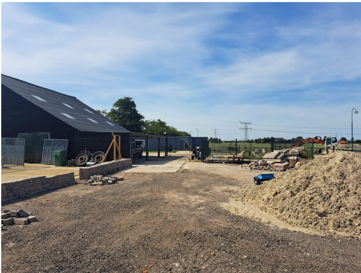
Figuur 4: Huidige situatie, achterzijde perceel (bron: A.J. Schievink).
