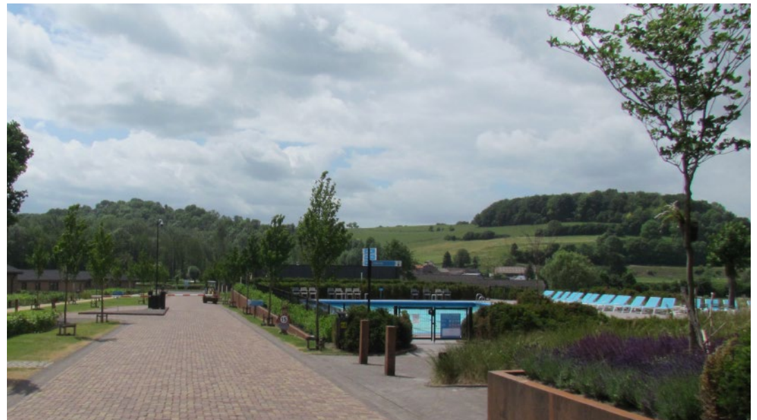
Zicht vanaf de entree over de centrale hoofdas.
