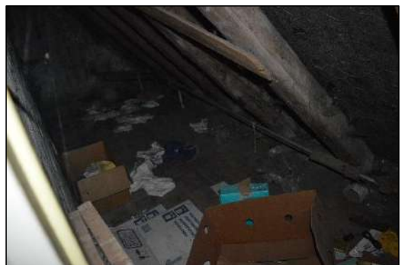
Afbeelding 2.17. Berging onder dak noordzijde woning.
