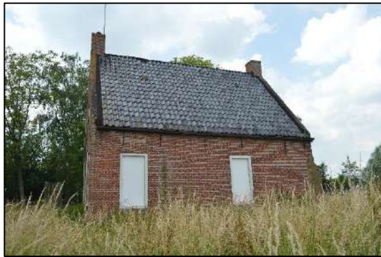
Afbeelding 2.2. Woning binnen plangebied, gezien vanaf oosten.
