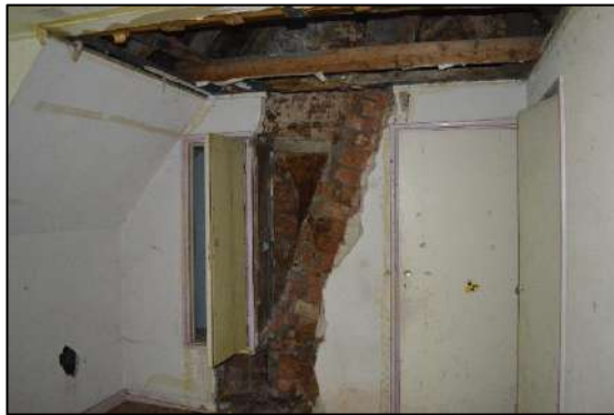
Afbeelding 2.14. Slaapkamer met kapot plafond.
