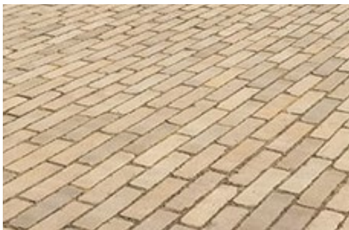
Geel getinte kleiklinkers als verharding plein, kiss & ride en fietsparkeerplaatsen
