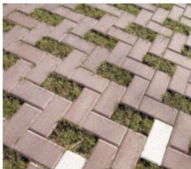
Figuur 25: Greenbricks, (Struyk Verwo Infra , Z.d.)
