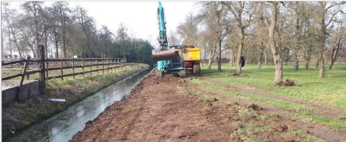
Aanleg natuurvriendelijke oever
