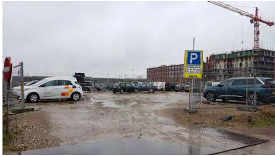
Figuur 2. Kavel V vanuit noordelijke richting gezien
