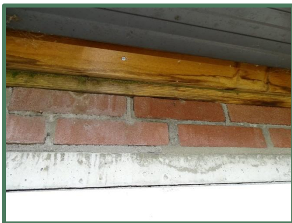
Muurplaat direct op de spouw
