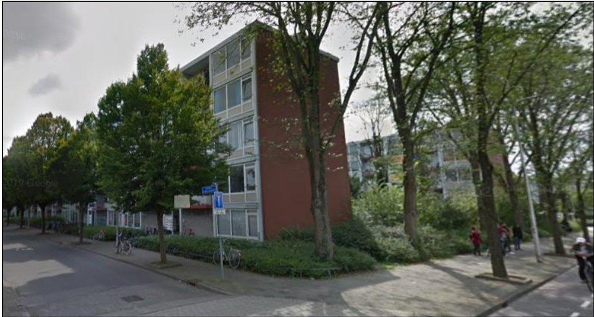
Afbeelding: de blinde kopgevels langs de Taagdreef (bron: Google Earth)
