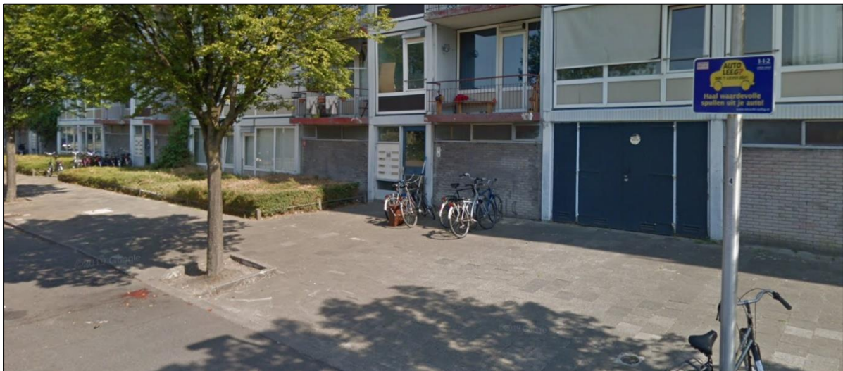
Afbeelding: een deel van de begane grondlaag van de portiekflat Vader Rijndreef 2-100 (bron: Google Earth)
