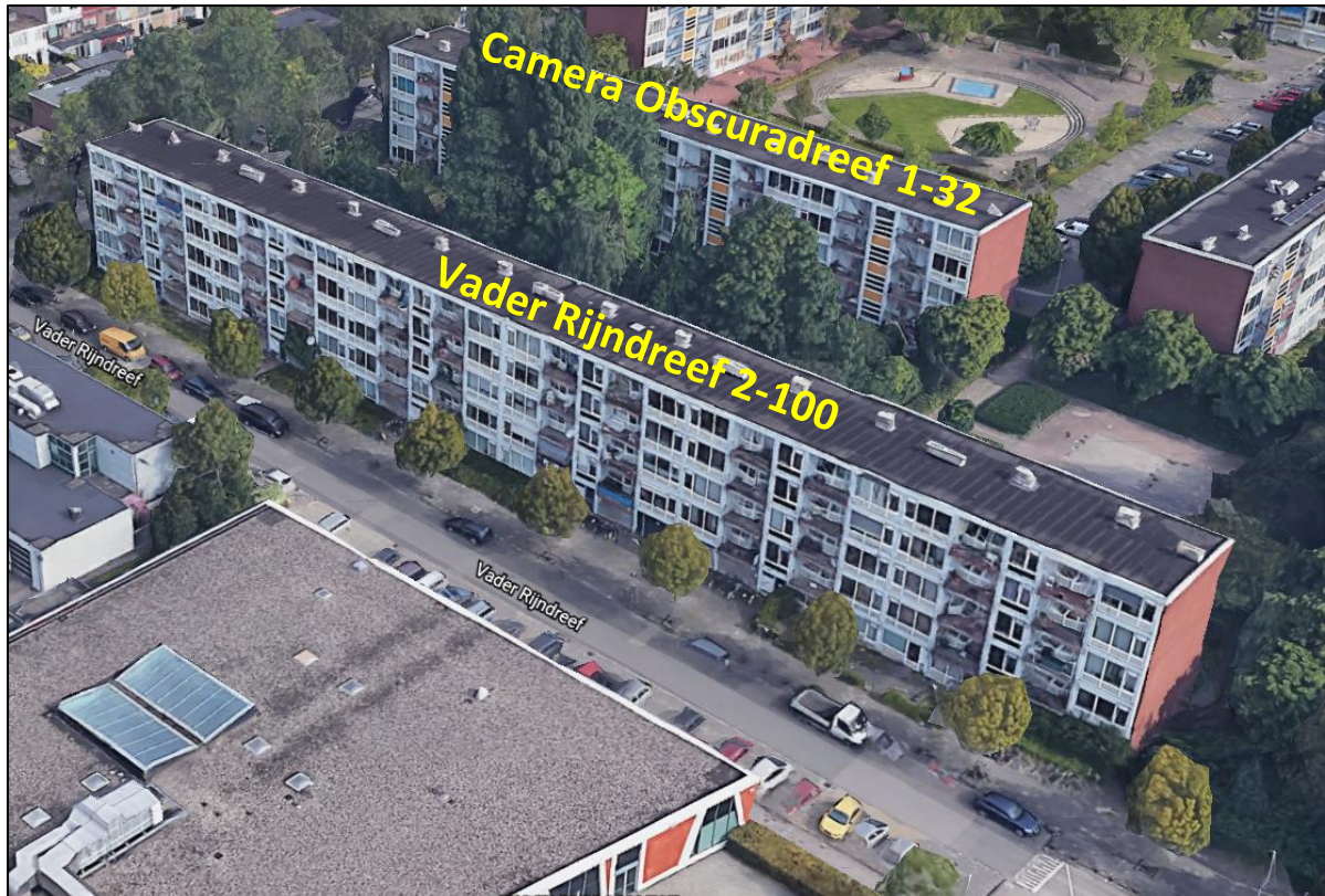
Afbeelding: de portiekflats op de projectlocatie (bron: Google Earth)
