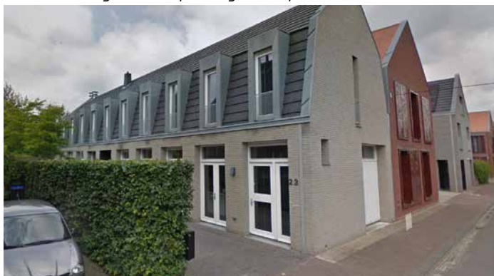
voorbeeld goede toepassing dakkapellen in mansardedak
