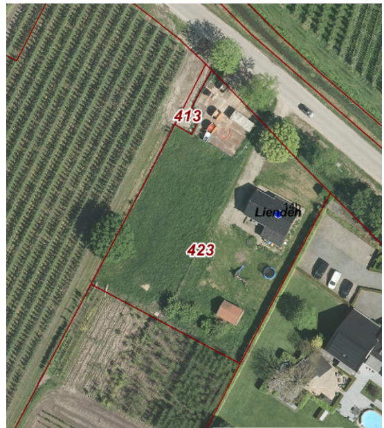
Afbeelding 2 luchtfoto van het perceel
