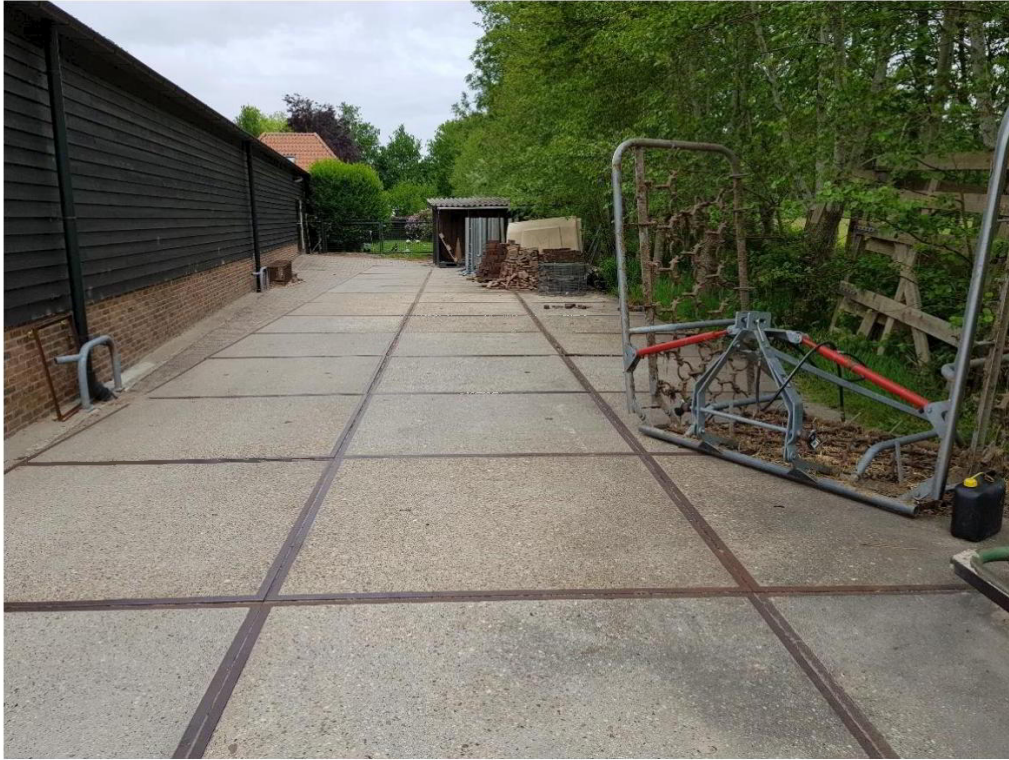
Oostzijde paardenstalling (stelconplaten)
