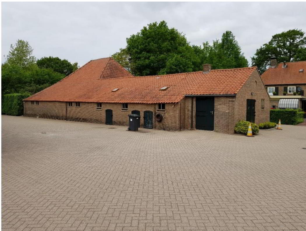
Erf met schuur en woning/kantoor (achtergrond)
