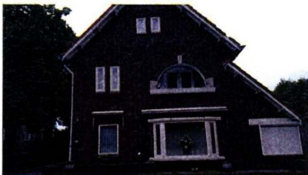
Reeds gesloopte woning en opstallen
