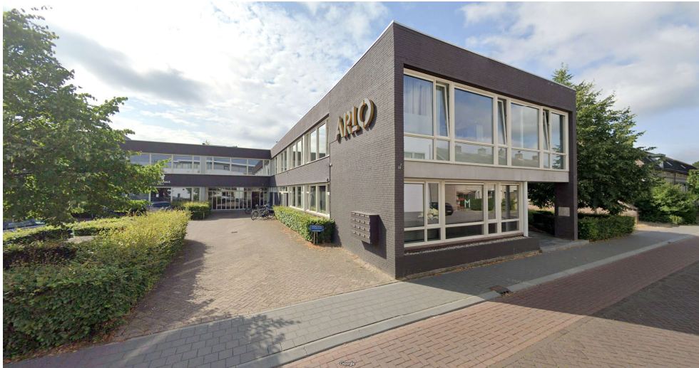
Voorzijde van de bestaande kantoorbebouwing in het projectgebied
