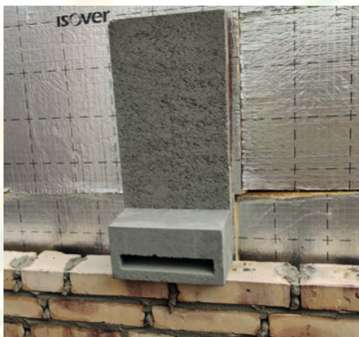
Figuur 6. Inbouw vleermuiskast, type VMP1e. Verkrijgbaar bij www.unitura.nl
