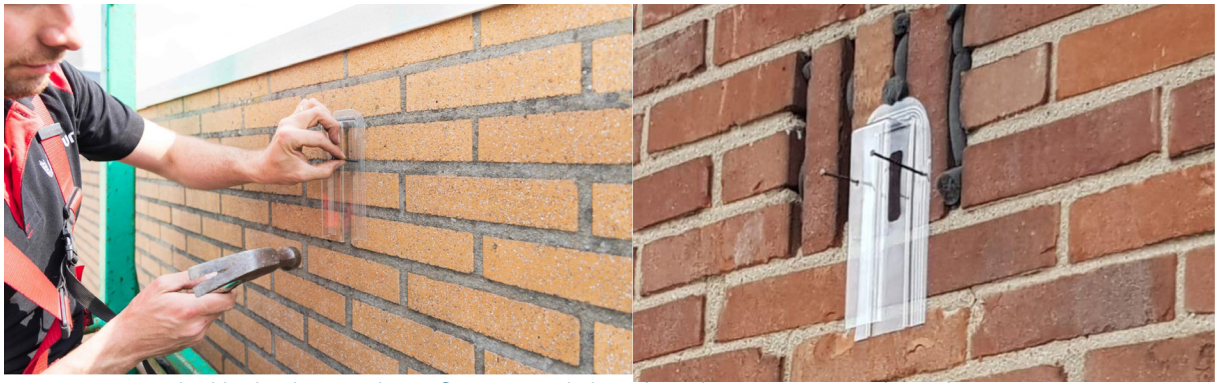
Figuur 9 - 10. Voorbeeld gebruik van exclusion flaps i.c.m. vulschuim bij invliegopeningen aan de gevel. Bron: Unitura
