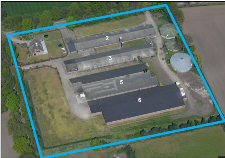
Afbeelding 3. Luchtfoto huidige situatie plangebied.
