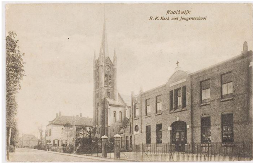
De pastorie (wit gebouw) de kerk, de kosterswoning en de school.
