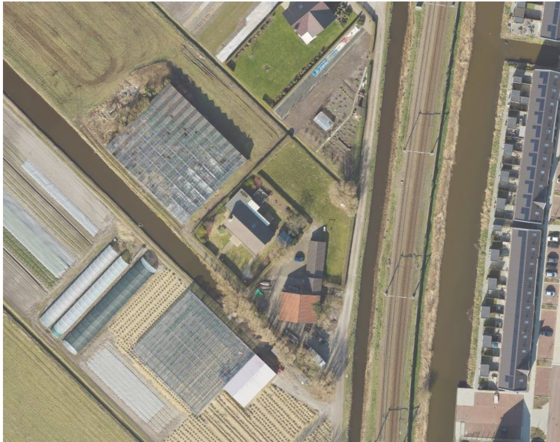
Afbeelding luchtfoto bestaande situatie
