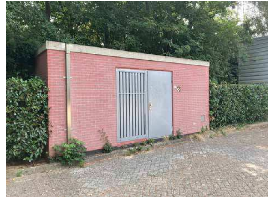
Trafohuisje op locatie
