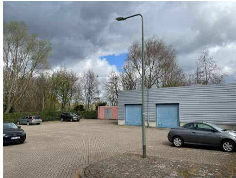
Trafohuisje? op plot
