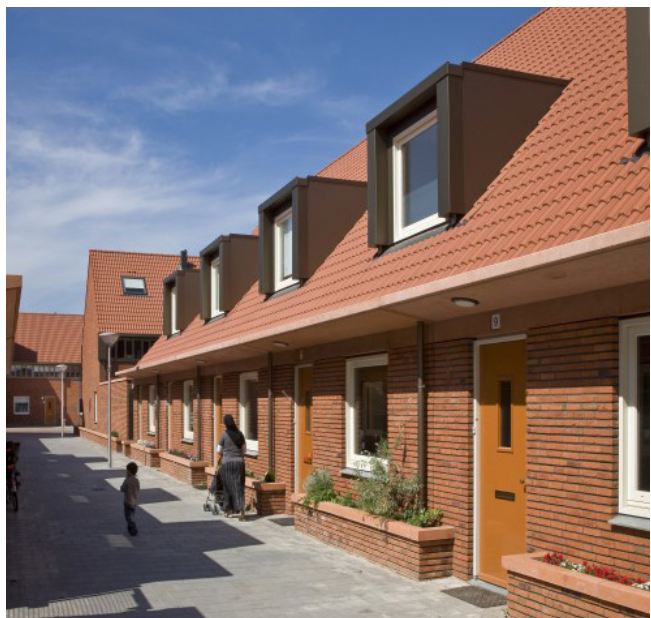
Referentie: dakkapel ondergeschikt aan dakvlak
