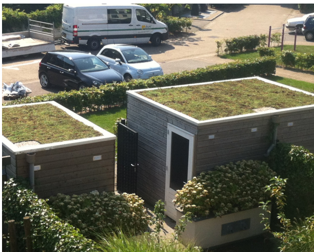
Referentie: sedumdaken op bergingen
