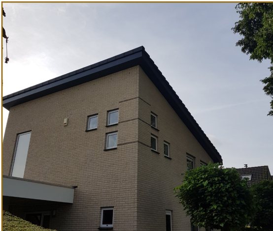
Afbeelding 2.3: Een gevel nabij het plangebied met daarin open stootvoegen welke mogelijk toegang bieden tot een verblijfplaats van vleermuizen.
