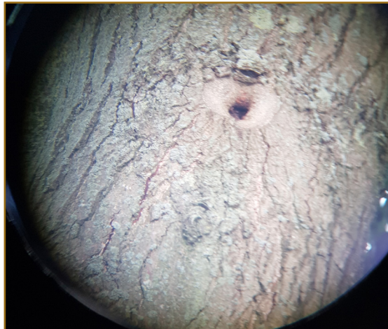
Afbeelding 2.9: Oude snoeiwond welke ondiep is en daarmee niet geschikt als nestplaats voor broedvogels of als verblijfplaats voor vleermuizen.
