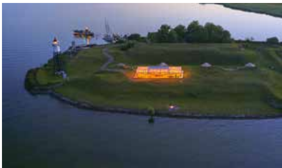
Fort Vuurtoereneiland - zomerrestaurant buiten en winterrestaurant in de kazerne.
