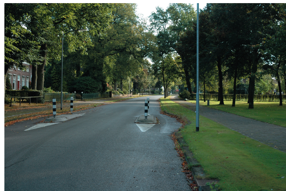
Huidige situatie Noordbargerstraat; asfalt en losliggende voetpaden
