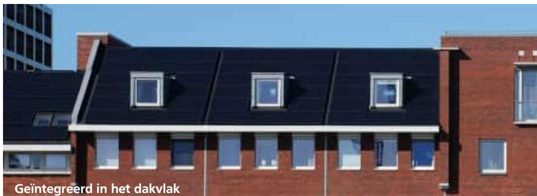
Geïntegreerd in het dakvlak
