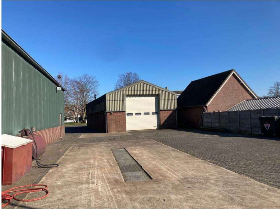
• Afbeelding 15: verhard erf met gedeelte te slopen gebouwen
