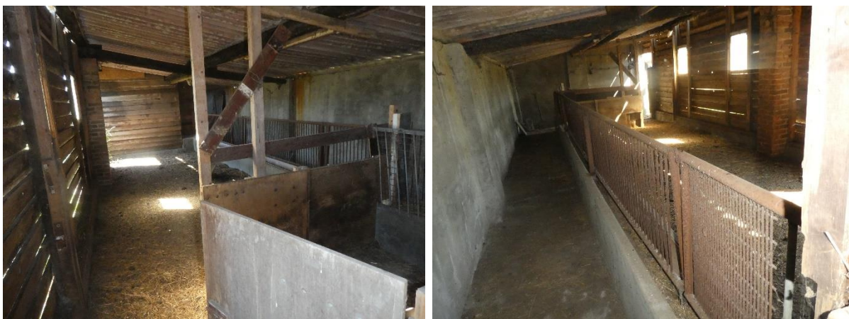
Afbeelding 21 t/m 26: Bestaande te slopen bebouwing. Bron: BNL advies. Datum: 14-06-2023
