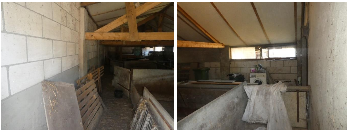
Afbeelding 15 t/m 20: Bestaande te slopen bebouwing. Bron: BNL advies. Datum: 14-06-2023
