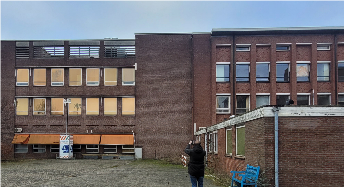
Achtergevel bouwdeel A. Rechts fase 1, links fase 2.
