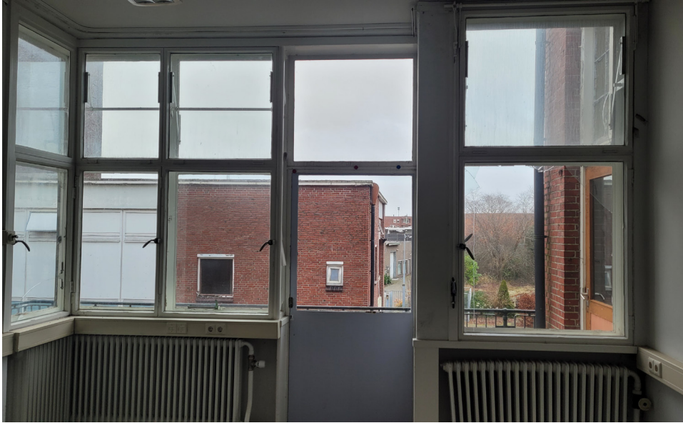
Interieur bouwdeel F. Stalen kozijnen
