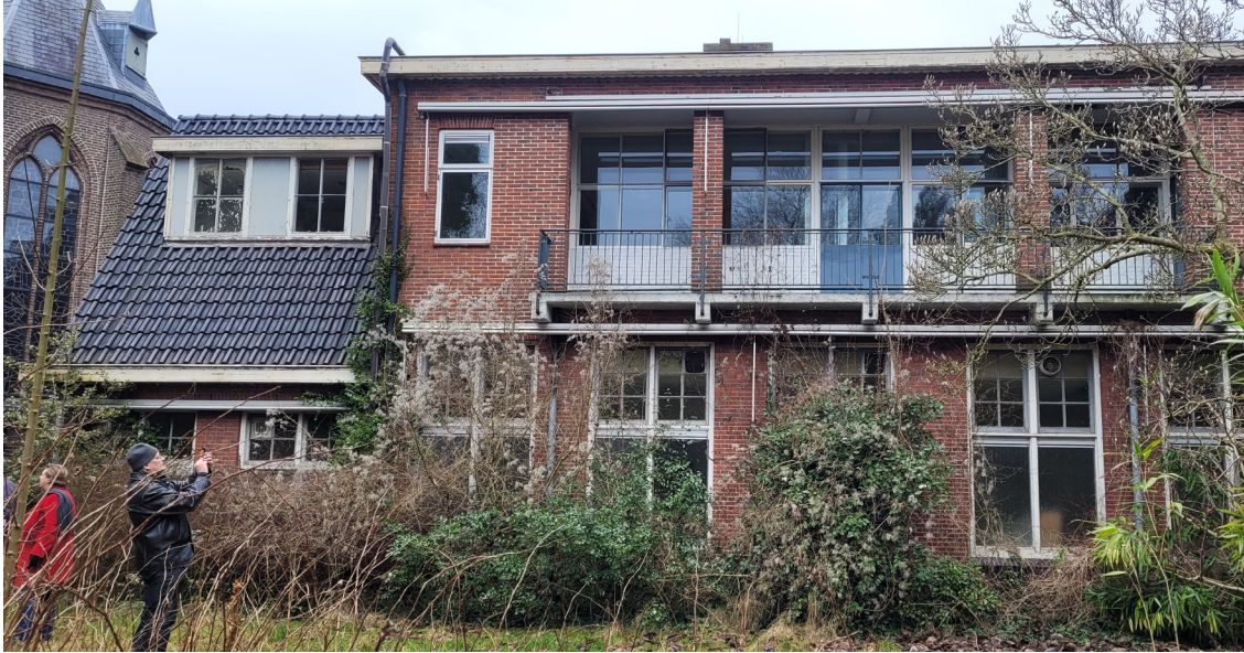
Bouwdeel F met buitenruimte en originele (?) kozijnen op de begane grond
