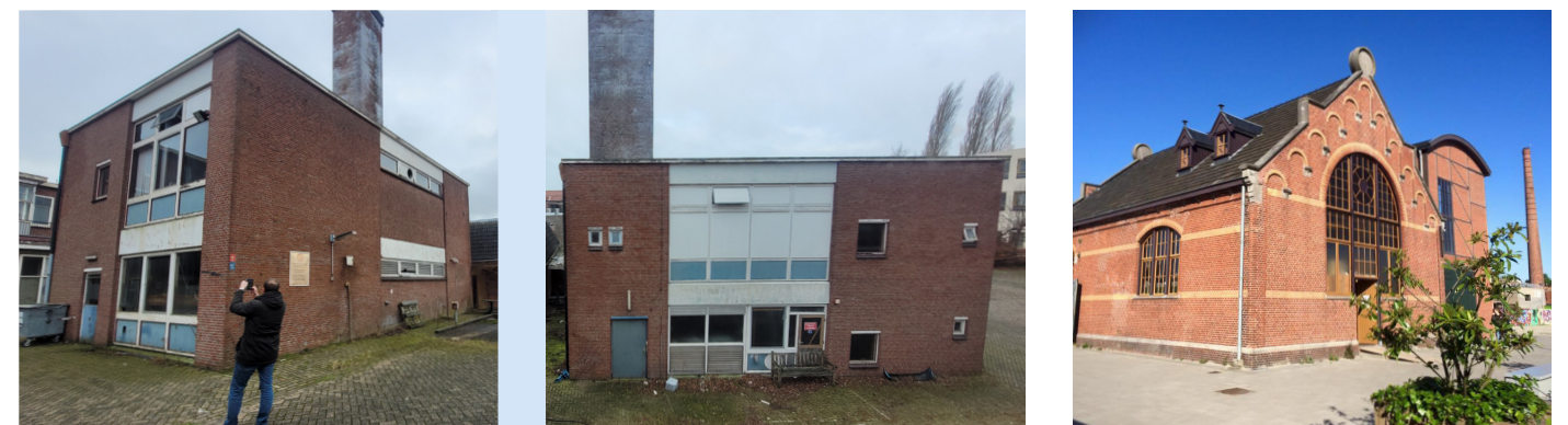
De gevel is vrij gesloten, maar niet dragend. Een goede verbouwing zou de kwaliteit van het pand flink kunnen laten toenemen.
