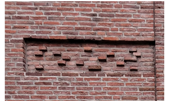
Voor de uitbreiding is eenzelfde soort verbijzondering in het metselwerk gebruikt als aan de achterkanten van bouwdelen B en D.
