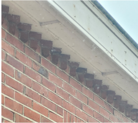
Detail goot bouwdeel E en F
