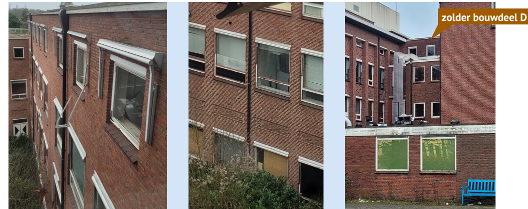
Bouwdeel D met verbijzondering in het metselwerk. Rechts verscholen achter bouwdeel H.
