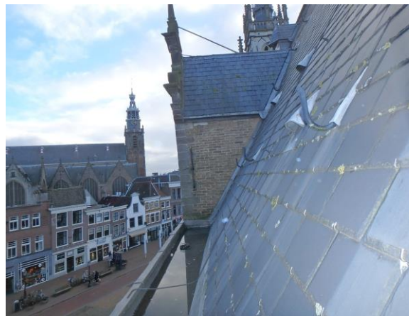
overzicht zijwand dakkapel
