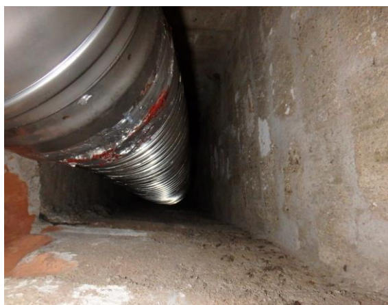
overzicht binnenzijde schoorsteen
