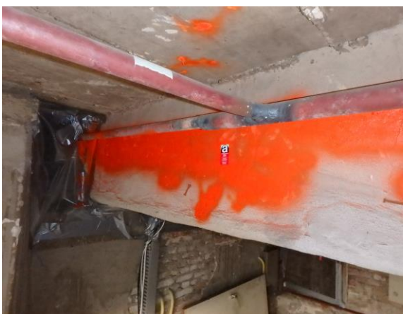
overzicht veiligstelling met coating restanten boven bodekamer
