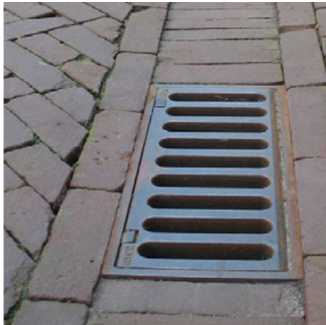
afwatering: Gootelement, straatkolk type: C20, ODS
