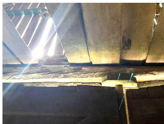
Het hout is duidelijk met een dissel gekantrecht. Erboven de slieten van de zolder. Gebintligger boven de niendeur.
