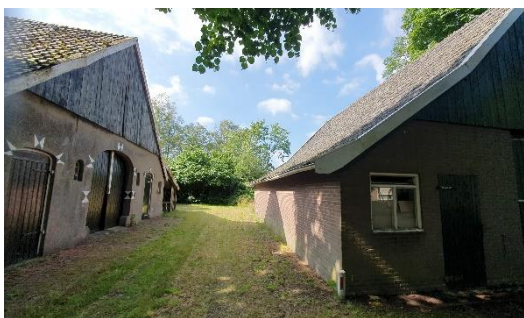
De schuur naast de achtergevel
