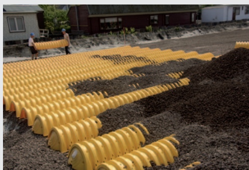
Aanleg ondergrondse waterberging Leidschendam. Foto: gemeente Leidschendam-Voorburg
