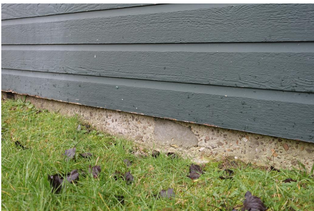
Figuur 8. Blik op de fundering van het gebouw. Onderkant is van beton met houten opbouw. Er is geen kruipruimte aanwezig. Foto Johan Krol. 7-1-2021.
