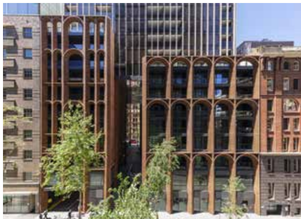
2 Rotterdamse laag als podium voor terugliggende hoogbouw.
