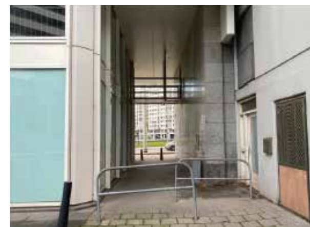
Doorgang woongebouw Pompenburg en kantoor AEGON.
