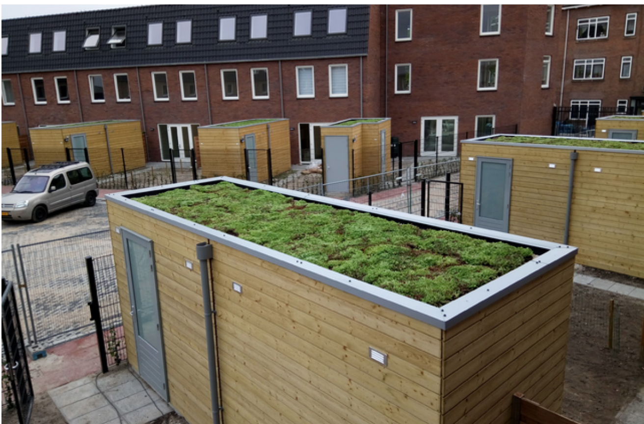
Voorbeeld van een groen dak, dat mensen eenvoudig zelf kunnen (laten) aanleggen op bijvoorbeeld een schuurtje.
