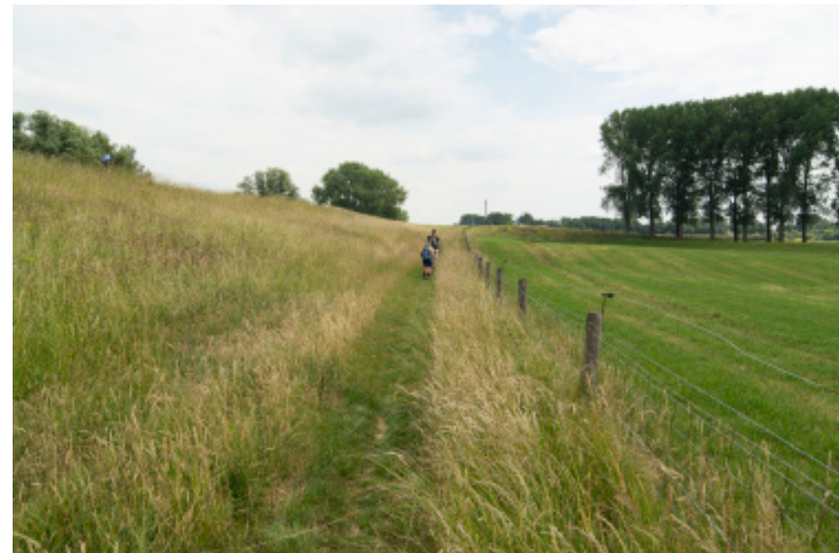
... maar onderaan de dijk
