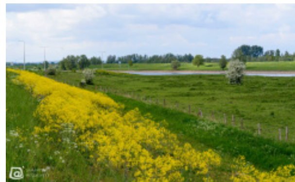
Bloemrijke grasmengsels op de dijk en de steunbermen
