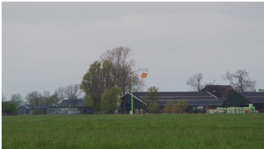
Kleine windturbine (15 m) bij een boerderij in de provincie Groningen (foto A&W).
