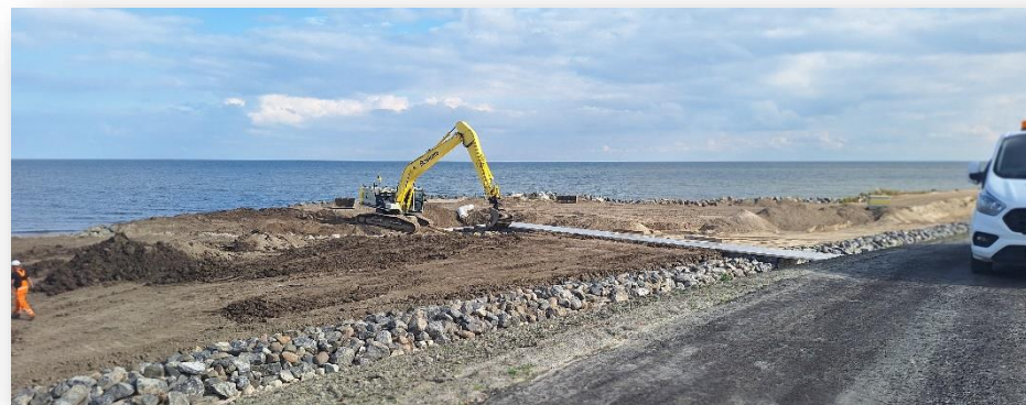
Werkzaamheden aan de Markermeerdijken
