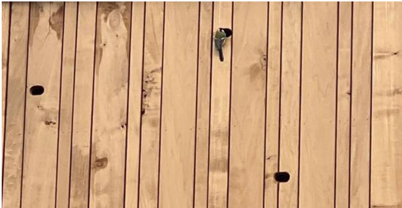
Nestkasten achter gevelbekleding
