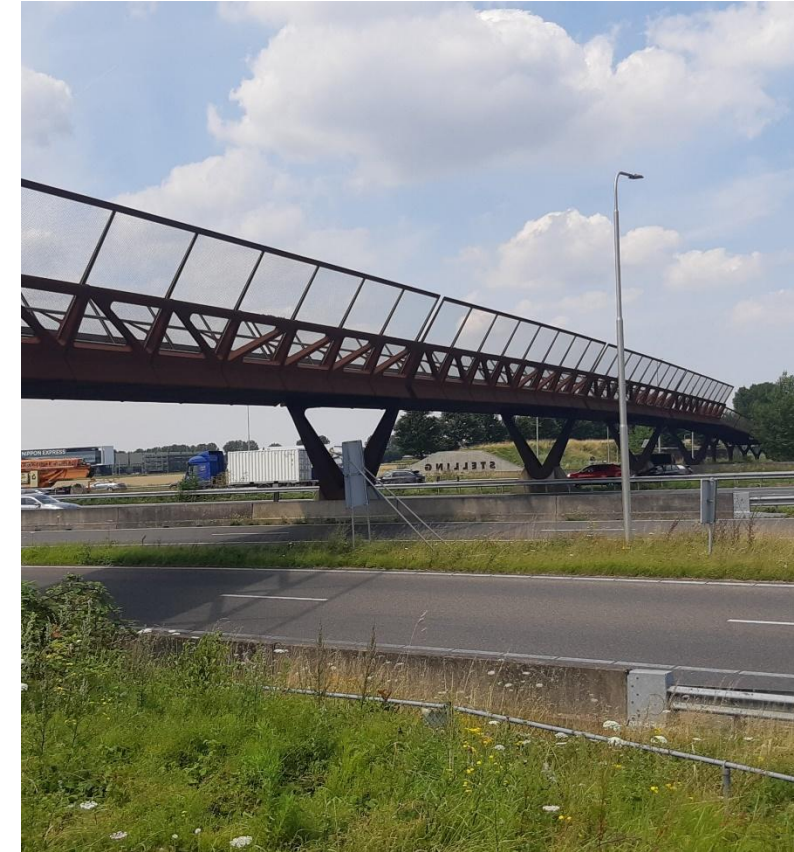
Kick Pruijsbrug, Hoofddorp
