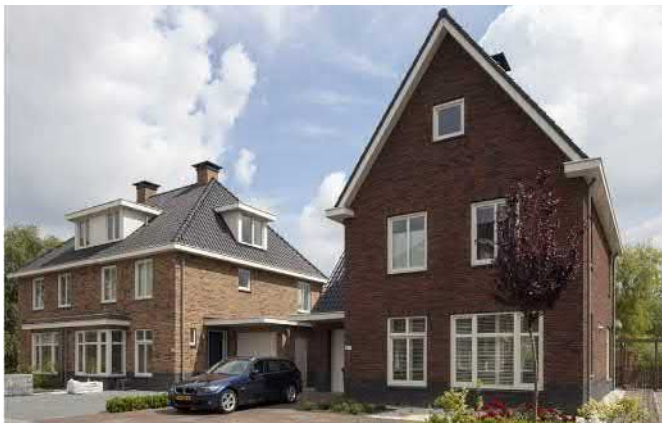
▷ Vrijstaande woningen hebben een dwarskap
