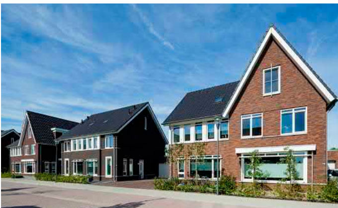
▷ Kleur metselwerk verschillen onderling voor een gevarieerd straatbeeld.
