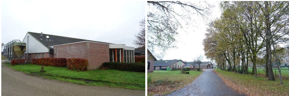
Afbeelding 9 en 10: Aanwezige beplanting op de kavel nabij de te slopen stallen. Bron: R.J.L. Bijvelds Datum: 03-12-2020
