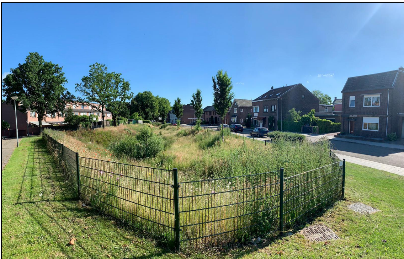
Figuur 5. Gecreëerde berging ten behoeve van de opvang van hemelwater.
