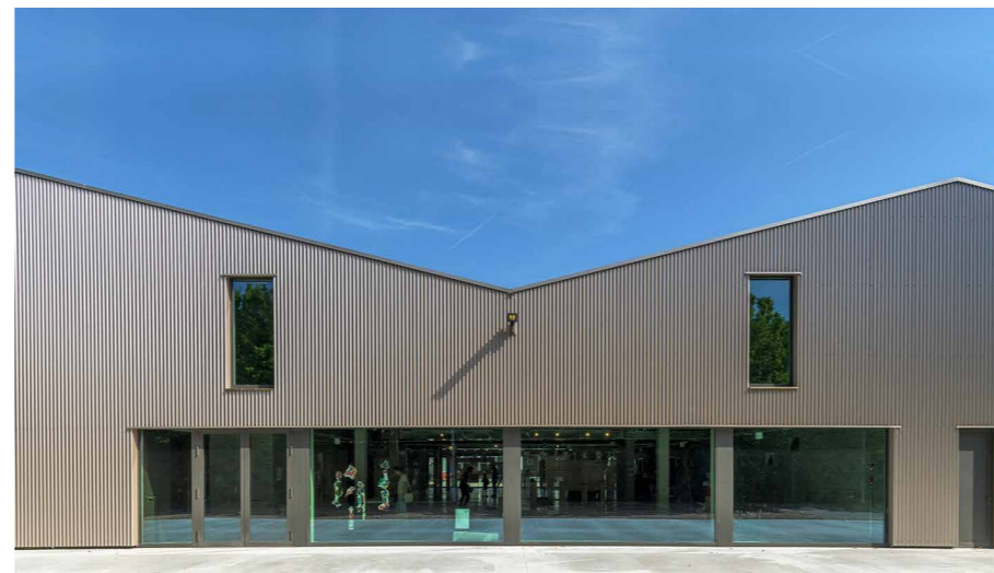
Referentie deelgebied 2: Gevelopeningen
