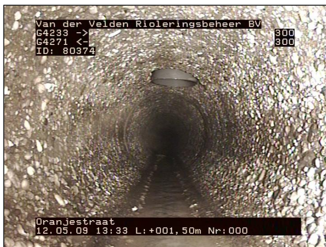
Figuur 1: Inspectiebeelden riolering Oranjestraat (bron: Van der Velden Rioleringsbeheer BV)
