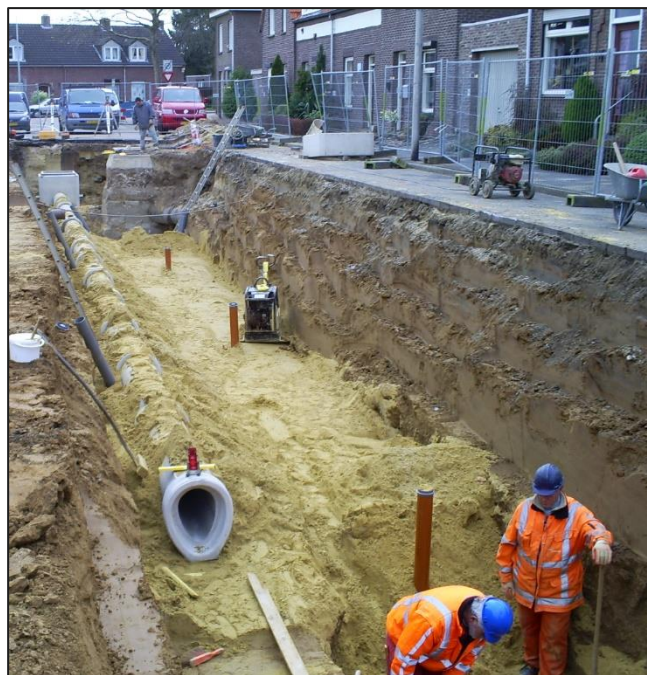
Figuur 4: Aanleg riolering
