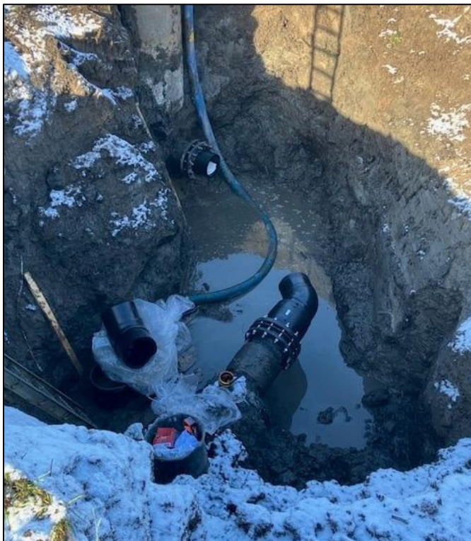
Afbeelding 4-5: Reparatie van een persleidingbreuk in februari 2025
