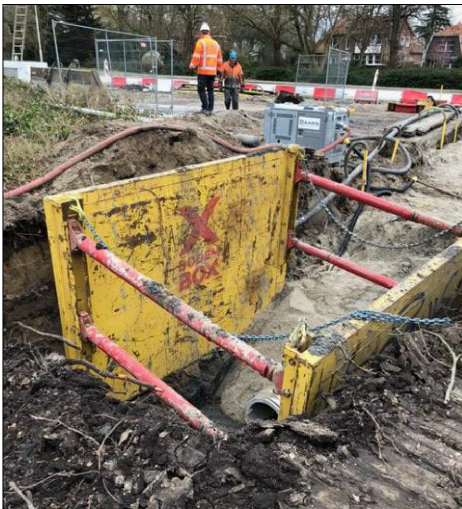
Afbeelding 4-3. Aanleg hemelwaterriool in de Banneweg
