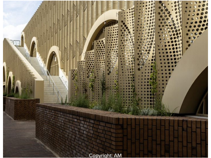
Copyright: AM Figuur 46. Zorgvuldig ontworpen gevels met vegetatie. Nijmegen, parkeergarage Waalsprong.
