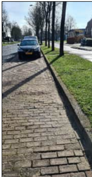
Afbeelding 4 t/m 6: Wortelopdruk in het fietspad, voetpad en parkeerstrook
