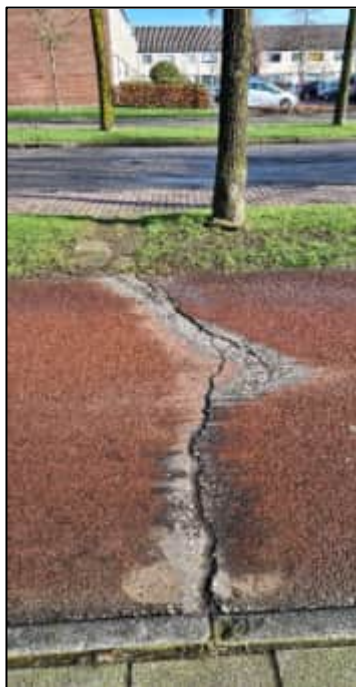
Afbeelding 4 t/m 6: Wortelopdruk in het fietspad, voetpad en parkeerstrook
