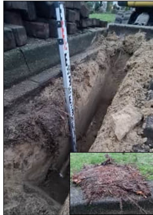
Afbeelding 16: Wortelplaat tussen bestrating en cunetzand
