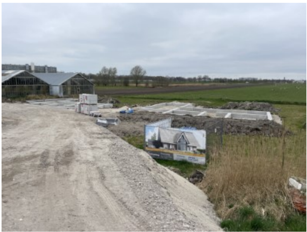
BOVENKERKERWEG 127. De fundering ligt er inmiddels voor 2 vrijstaande villa's die in de verkoop staan.
